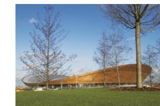
ロンドンオリンピックパークの木造建築物や選手村の内装、チケット、プログラム等 ©Olympic Delivery Authority (ODA)(2012)
