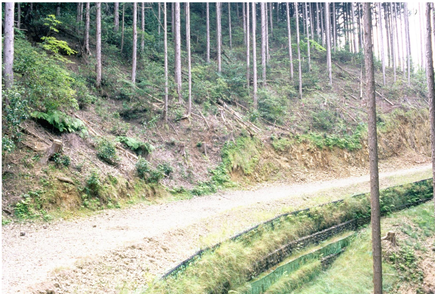
鋼製L型土留壁（L型メッシュウォール）
